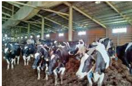
写真2 屋根裏+壁の断熱材
