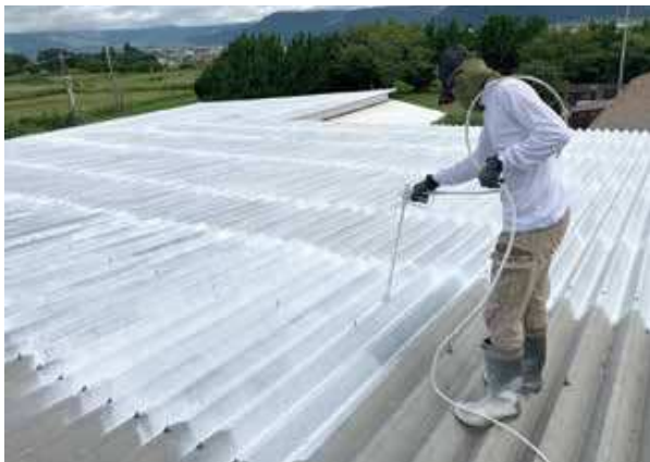
【写真6】 石灰塗布の様子
